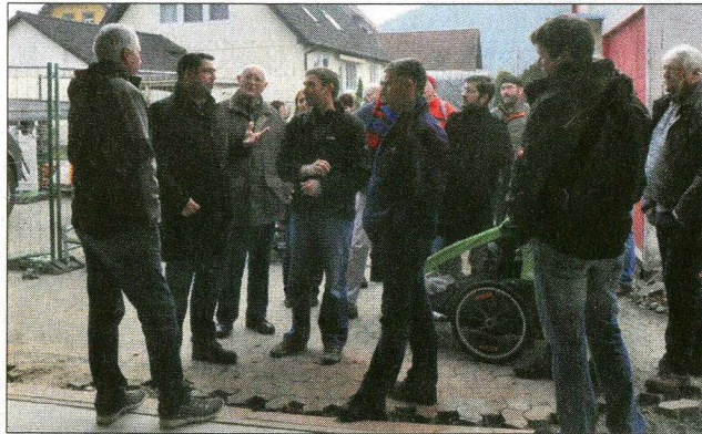
Philipp Saar (Zweiter von links) an der Baustelle des Schnellinger Feuerwehrgerätehauses Foto: Kleinberger
